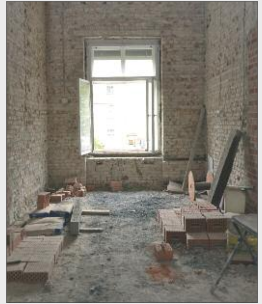
Bis Ende 2016 sollen die Bauarbeiten an der neuen Zahnklinik abgeschlossen sein.
