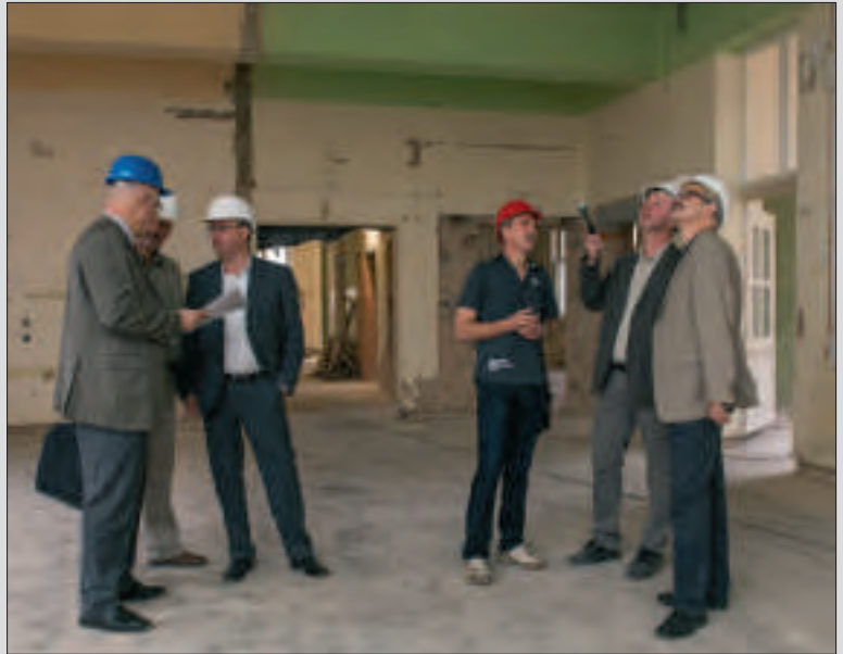
Besichtigung der Baustelle der Zahnklinik im Sommer 2015. Nach einer Klage verzögerten sich die Bauarbeiten. Foto: Archiv
